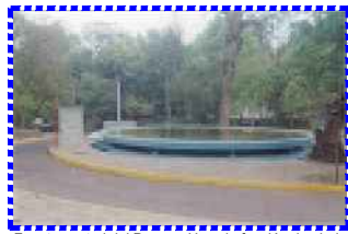
Fuente central del Parque. Hace la función de glorieta para la operación de las pipas de agua; ya no se utiliza como fuente
