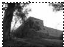
Vista sur de la barda de la antigua fábrica desde el Parque Nacional "Fuentes Brotantes".
