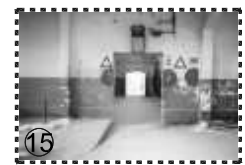
15 Pasillo de acceso a las naves de la Fábrica, vista hacia el exterior.
