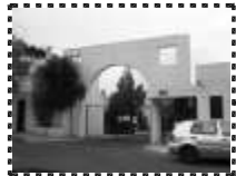
Acceso a la unidad habitacional colindante con la antigua fábrica la fama, por calle Sor Juana Inés de la Cruz.
