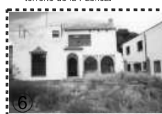
6 Viviendas existentes en el interior del terreno de la Fábrica.
