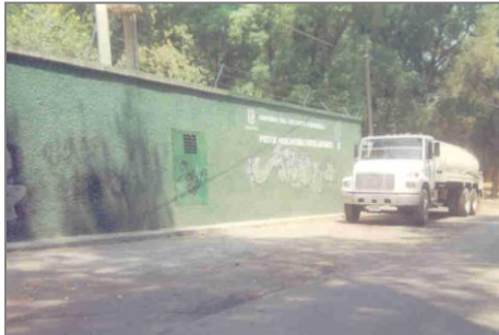
Fig. 5. Pozo de suministro de agua potable propiedad de la DGCOH localizado en el interior del Parque Nacional “Fuentes Brotantes”.
