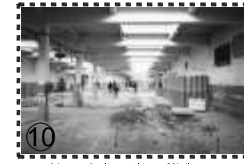
10 Nave de la antigua fábrica.
