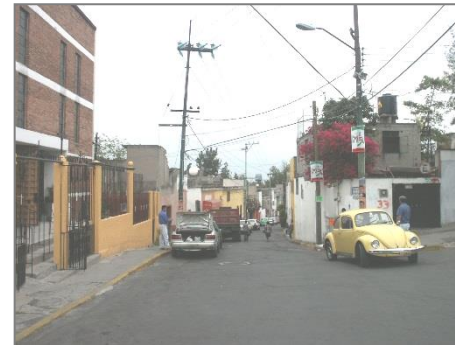
Fig. 14. Red eléctrica aérea con la que cuenta el Barrio La Fama Fuente: Acervo propio
