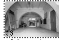
16 Pasillo que conecta las áreas de bodega.
