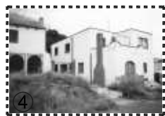
4 Vivienda deshabitada en el terreno de la Fábrica.
