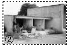
2 Zona que funcionaba como bodega para la Fábrica.
