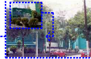
Acceso al Parque Nacional "Fuentes Brotantes" por Av. Insurgentes. Se observa vandalismo en las bardas.
