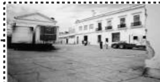
"LA CAPILLA" INTERIOR DEL INMUEBLE DE LA ANTIGUA FÁBRICA "LA FAMA MONTAÑESA"
