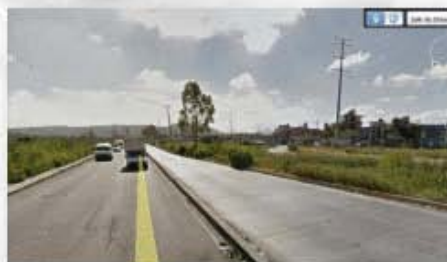
Lado norte de la venida bordo Xochiaca, vista de arrollo vehicular y Carril de Mexibus.
