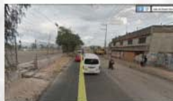
Lado sur de la venida bordo Xochiaca, vista de arrollo vehicular, inexistencia de banquetas, fachadas en mal estado, con grafitis y sin repellados
