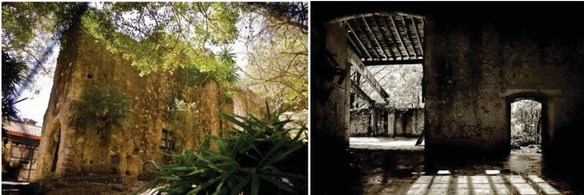
Imágenes 48-49. Bastos muros de piedra y grandes espacios interiores con cubierta de teja, característicos de la ex-haciendas mineras de Taxco. Ex hacienda de Cantarranas (“El Chorrillo”).
