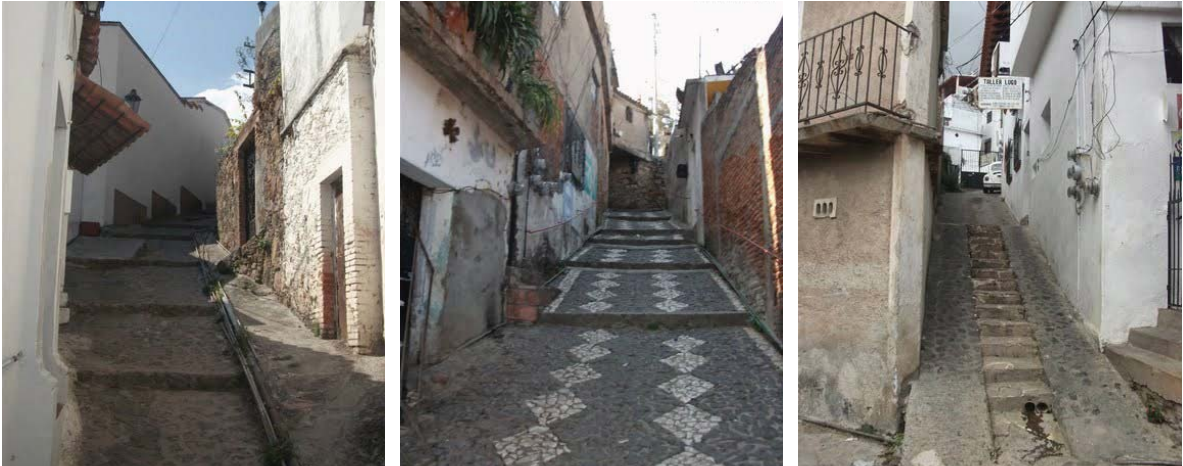
Imagen 34. Soluciones populares para desniveles en callejones: rampas, escaleras y rampas-escalera.
