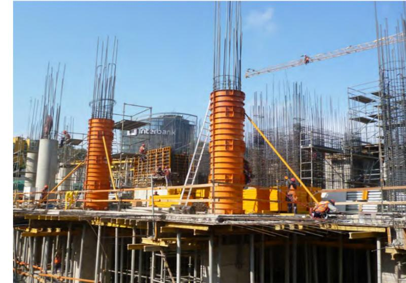
Armado y Cimbrado de Columna Cilíndrica
