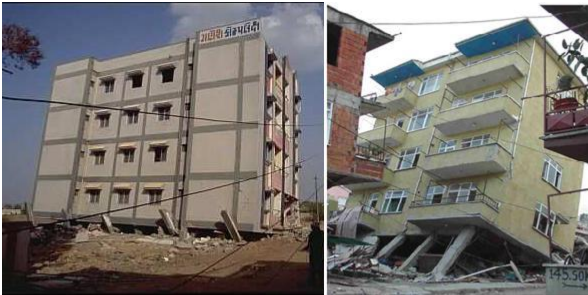
Fig. 7 Falla debido a excesivo desplazamiento lateral (Aditi H. & Vipin V., 2015).
