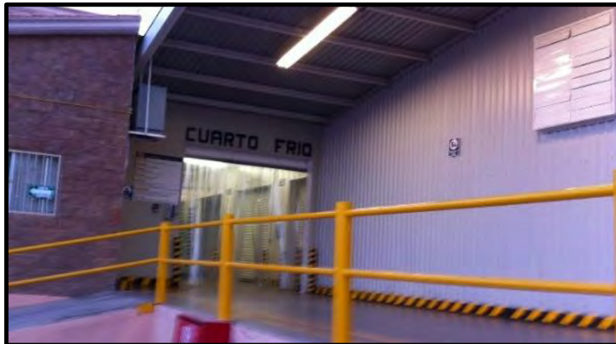
IMAGEN 10 COSTA DE HERMOSILLO: CUARTO DE ENFRIAMIENTO
