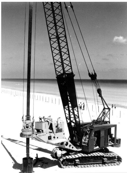
FIG. 5.3, PERFORADORA ROTATORIA MONTADA SOBRE GRÚA (WATSON)
