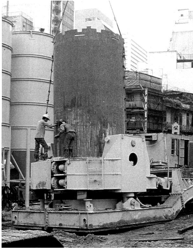
FIG. 5.39, COLOCACIÓN DE ADEME CON OSCILADORA
