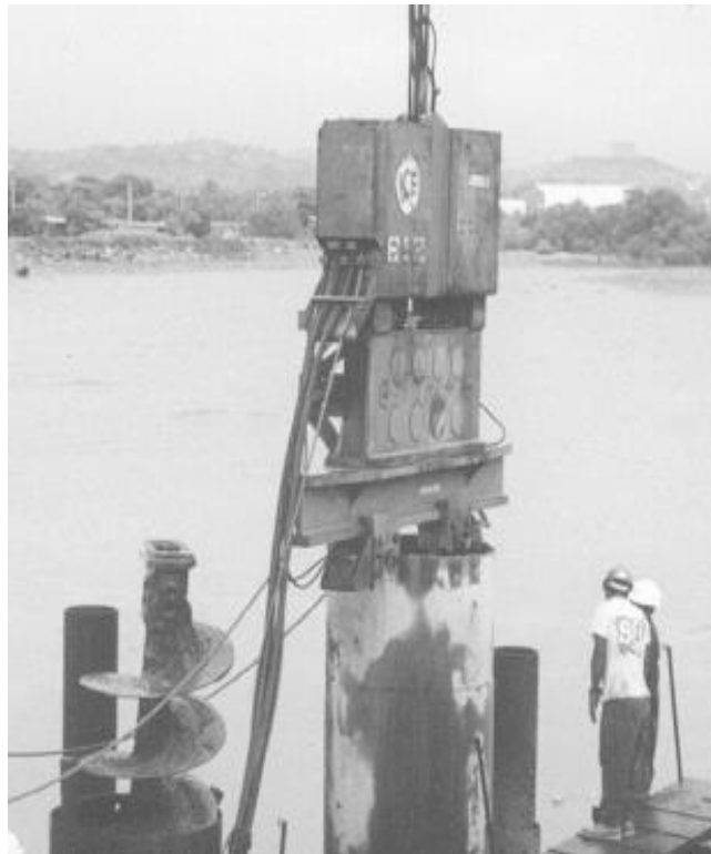
FIG. 5.38, VIBROHINCADO DE ADEME
