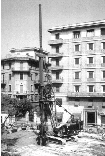
FIG. 5.7, ALMEJA HIDRÁULICA (CASAGRANDE)
