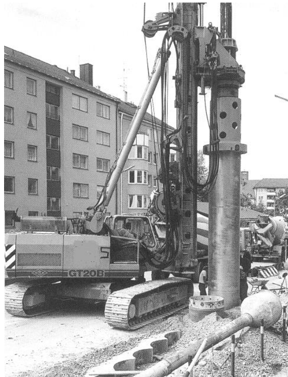
FIG. 5.41, COLOCACIÓN DE ADEME METÁLICO CON PERFORADORA ROTATORIA
