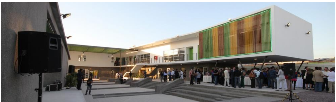
Ilustración 24: Patio Central del Centro cultural de Alto Hospicio 36
