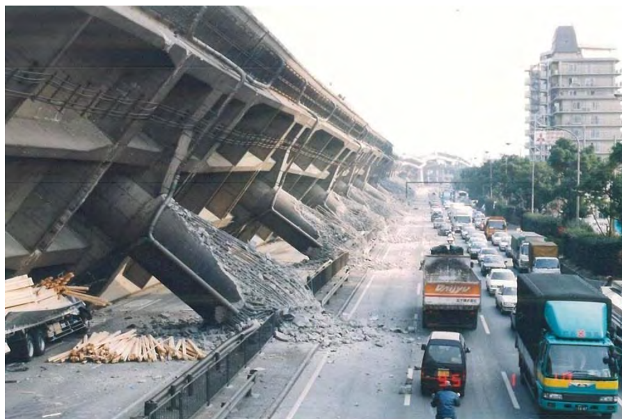
Figura 1.12 Daños a la infraestructura ocasionados por el terremoto de Kobe en 1995
