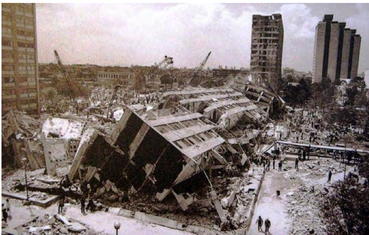
Figura 3.8. Edificio volcado, terremoto de la Ciudad de México en 1985
