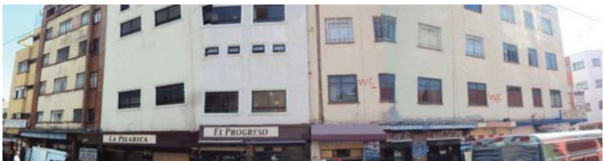
Vista Calle Aranda.
