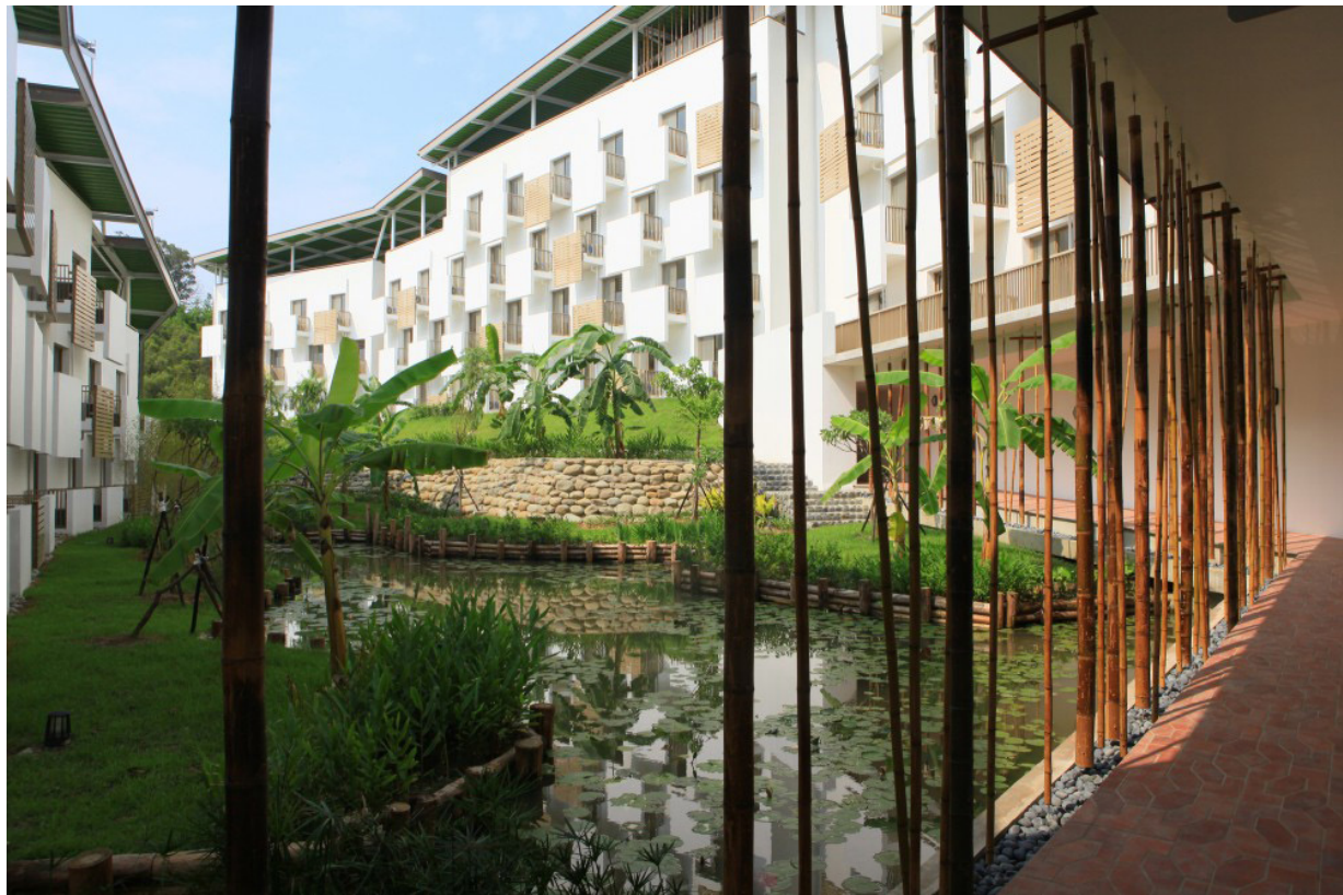
Vista Interior del edificio principal
