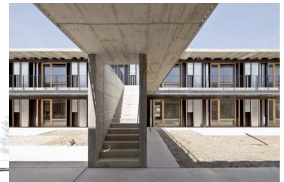
Acceso a segundo nivel
