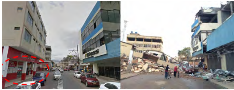
Figura 5: Antes y después de un edificio ubicado en el centro de Poroviejo con piso flexible, durante el sismo de Ecuador 2016. Fuente: Municipio de Balzar.
