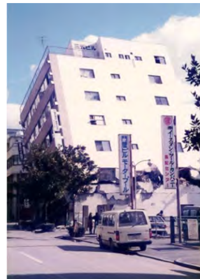
Figura 3: Colapso de un edificio con piso débil, durante el sismo de Kobe, Japón, 1995. Fuente: Tena (2010).
