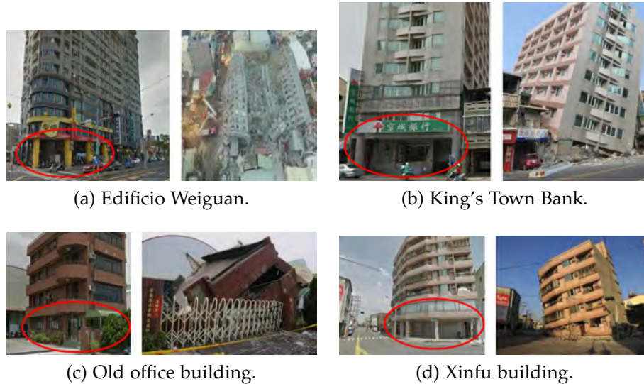
Figura 4: Antes y después de edificios colapsados en el sismo de Taiwán. Fuente: Taiwan Earthquake Clearinghouse website (2016).
