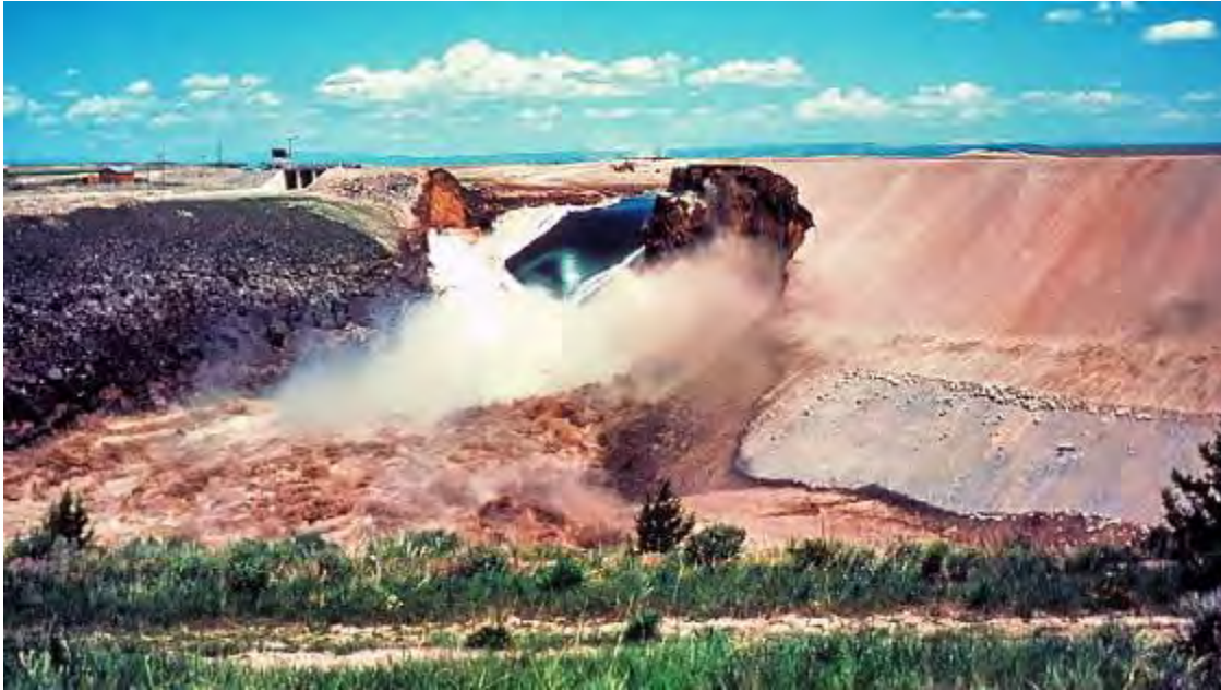
Figura 1.28 Vista del rompimiento de la presa Teton en Junio de 1976. Department of Earth Science, University of California (1976).
