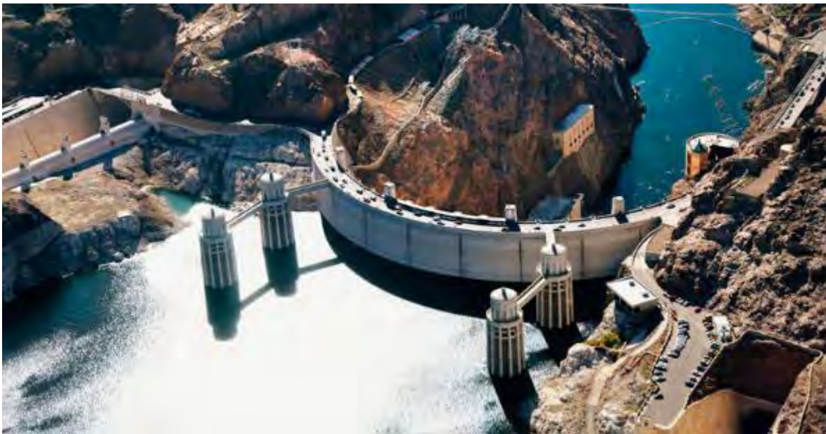
Figura 1.2 Presa Hoover tipo arco-gravedad. (2006).
