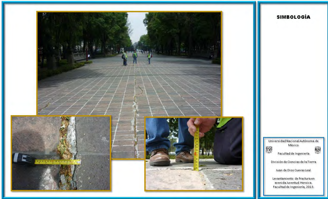
Figura 31. Levantamiento de fracturas en Avenida Juventud Heroica, Primera Sección del Bosque der Chapultepec. (Facultad de Ingeniería UNAM, 2013).
