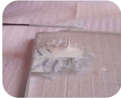
Fig. 19 Preparación del cemento sellador Silco
