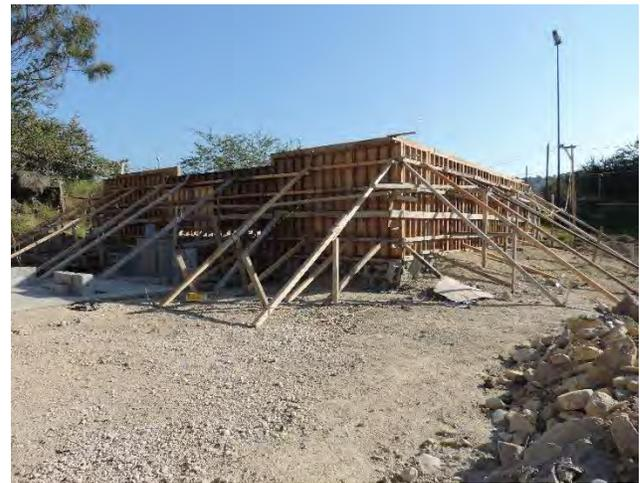
**Figura 4-77 Cimbrado final del tanque de almacenamiento**
