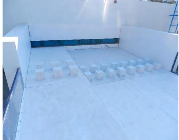
**Figura 4-97 Elementos disipadores de energía**
