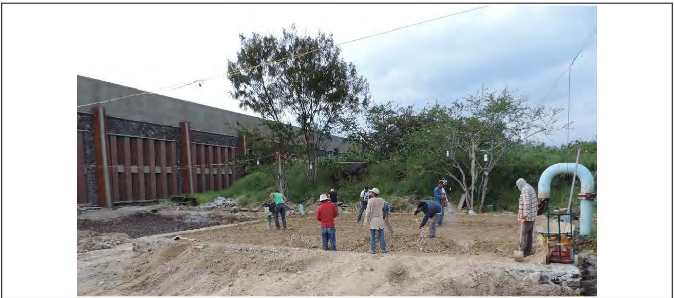
Figura 4-74 Nivelación y compactación del terreno
