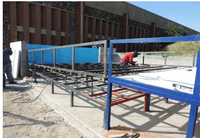
**Figura 4-82 Trabajos de soldadura en estructura metálica**
