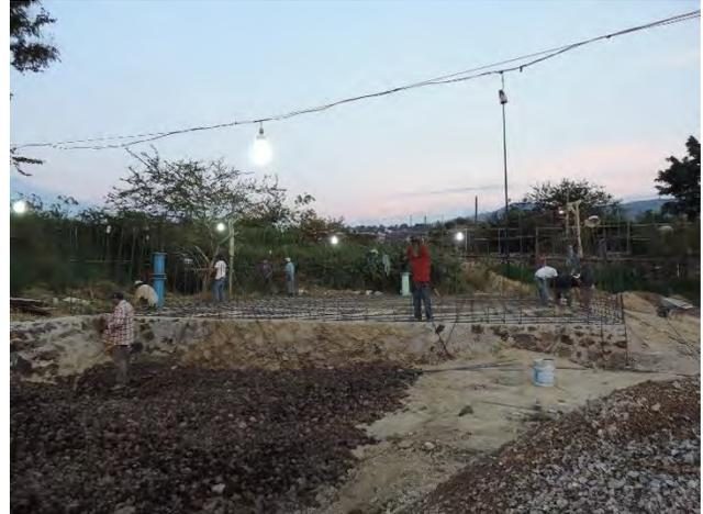
**Figura 4-75 Armado de varilla sobre firme de mampostería**
