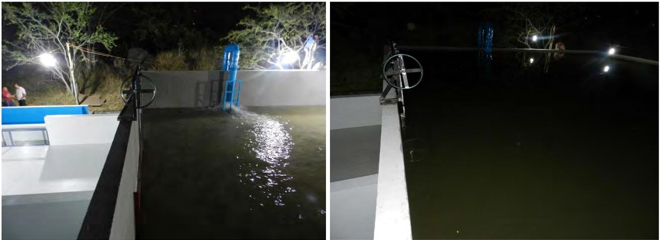
Figura 4-86 Primer llenado de tanque de almacenamiento
