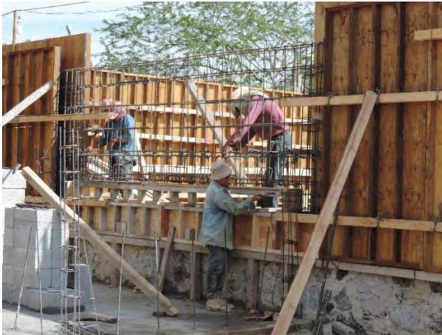
**Figura 4-76 Detalle en armado de compuerta**
