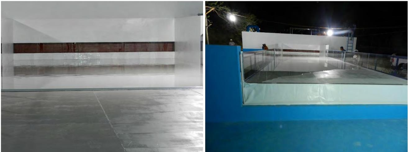
Figura 4-87 Filtración en la compuerta durante inspección de hermeticidad
