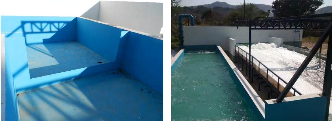
Figura 4-101 Vertedor rectangular de pared delgada, situado al final del canal de circulación
