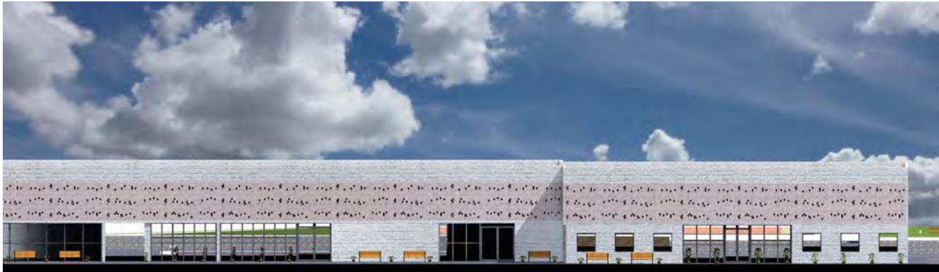
7.57 Fachada del edificio administrativo, cocina y comedor.
