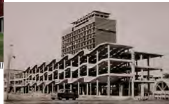
4.4.4 Construcción de la Torre de Ciencias
