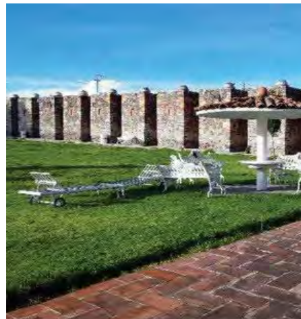
4.1 20 Habitaciones construcción de Piedra Orientación Noreste
