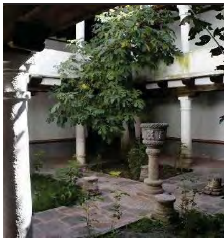
4.1 30 Patio central del Ex convento Oxtotipac, alrededor lo acompañan una serie de columnas que generan un ritmo y simetría, los materiales de la cubierta a base de vigas de madera.
