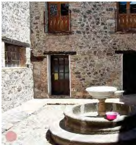
4.1 13 La materialidad de los muros macizos y el juego de vanos con madera hace que se integre y se unifique
