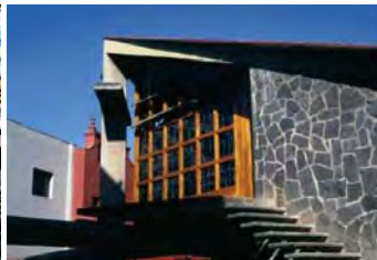
4.2 28 Escalera de concreto
