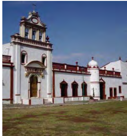
4.1 18 Fachada Sur Principal con arcos escazanos y conopiales.
