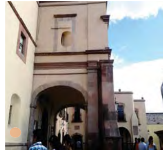
4.4.20 Acceso Ex Convento de San Francisco
