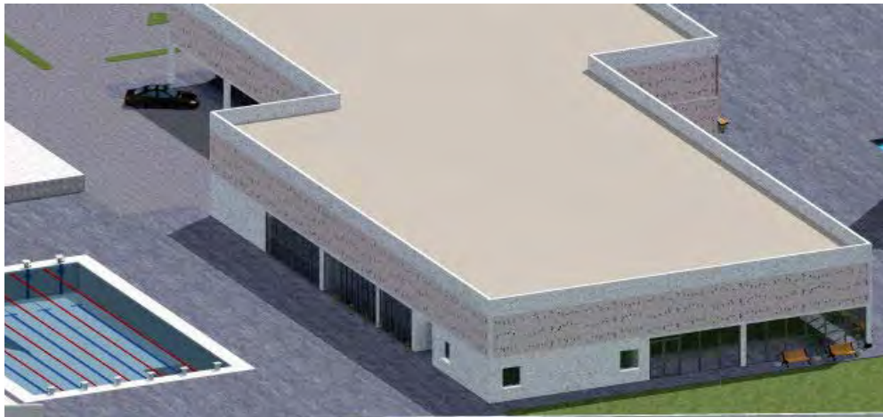
7.5 8 Vista posterior del edificio administrativo
