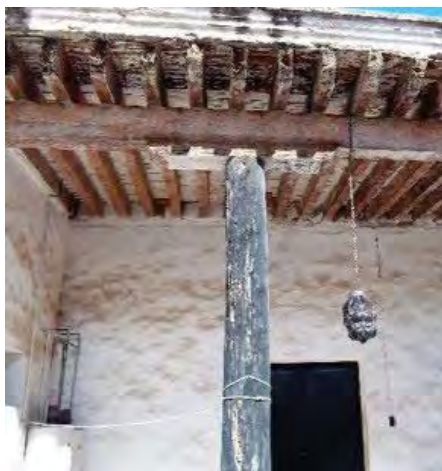
4.1 21 Materialidad de la construcción a base de Vigas y columnas de madera, muros de piedra mampostero
