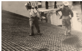
4.2 24 Habilitado del acero
