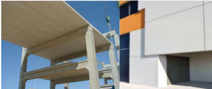
Figura 4.3 Sistemas prefabricados de piso y de fachada
