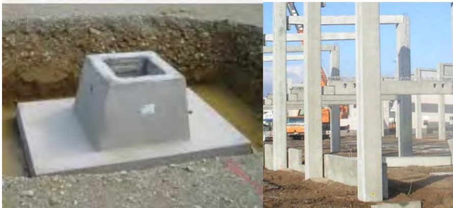
Figura 4.1 Columnas y zapatas prefabricadas
