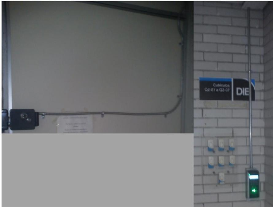
Figura 2.2 Dispositivo biométrico enlazado a cerradura mecánica
