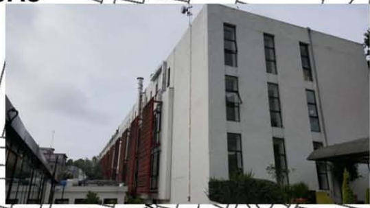
Imagen 16. Edificio principal del Hospital, Coyoacán, México. (Fotografía: Fabiola Chávez) 2015
