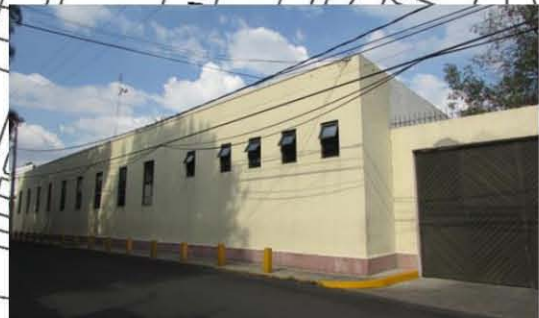
Imagen 17. Acceso vehicular para personal médico y al edificio posterior de Subespecialidades. Calle Vicente García Torres. (Fotografía: Fabiola Chávez) 2015
