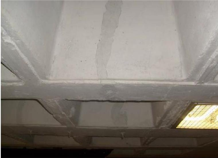
Reparación de grietas en losa nervada, sótano 1.
