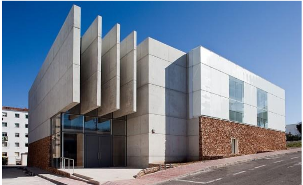
Fachada principal, cuenta con elementos verticales de concreto que están sobre la puerta y el hall de entrada. Fuente: www.joanroig.com
