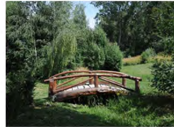
Puente en parque
