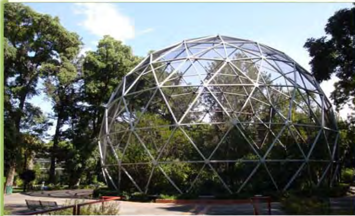
• Envoltorio de mariposario con estructura metálica
