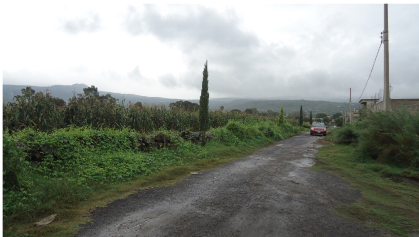
8. Cerrada los Pinos Fotografía propia La calle no está totalmente pavimentada y no cuenta con luminarias suficientes para el tránsito seguro.
