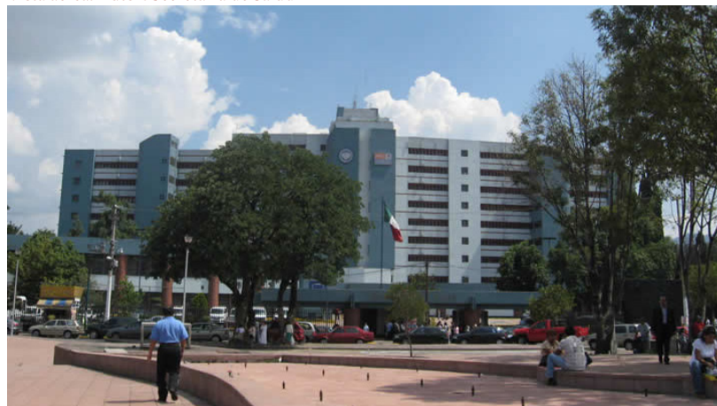
Acceso principal. Autor: Ibarreche, José.
