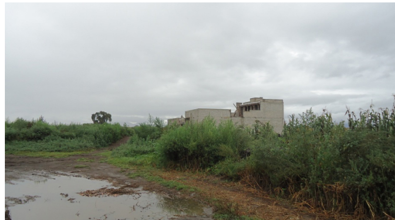
9. Cerrada los Pinos Fotografía propia Ya que el poblado es parte de una cuenca, el agua de lluvia tiende a acumularse en las zonas más bajas.
