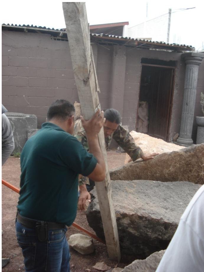
Fig. 28. Movimiento de una piedra utilizando el método de la palanca. Escuela taller del Cantero, Chimalhuacán, Estado de México, 2015.
