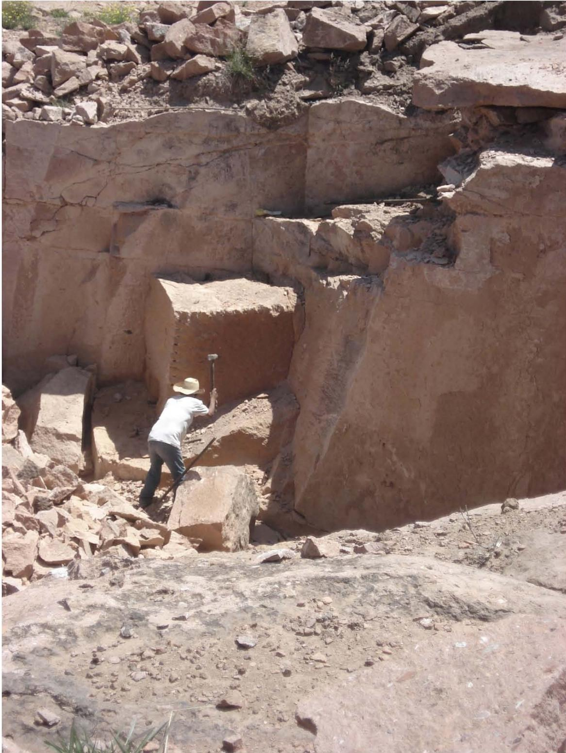
Fig. 23. Cantero trabajando en un yacimiento ubicado en Huichapan, Hidalgo, 2015. En la piedra que está frente a él se pueden apreciar los orificios dejados por las cuñas.
