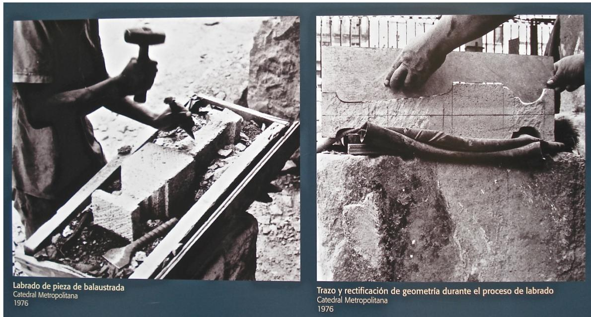
Fig. 36. Canteros en la obra de restauración de la Catedral de México labrando una balaustrada y utilizando una plantilla.
