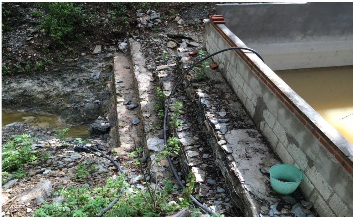
Figura 8. Fotografía del depósito de agua de Vidal Cruz.
