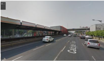
F1. Vista Calzada de Tlalpan dirección Norte-Sur
