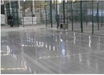
Fig. 55 - Piso de concreto pulido. Fuente: http://www.kisco.com.mx/pulido-pisos-concreto.htm
