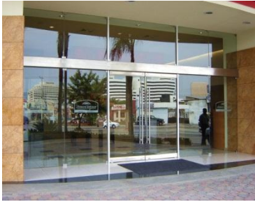
Fig. 61 - Ejemplo de puerta de cristal con marco de aluminio. Fuente: http://www.dialvi.com/web/categorias_obras/vidrios-templados
