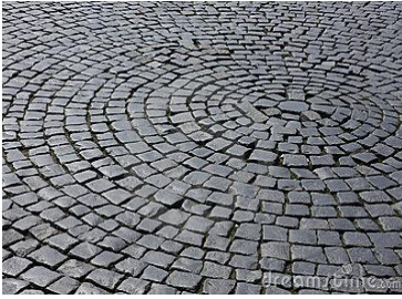
Fig. 44 - Adoquín cuadrado de 20x20cm y diseño del acabado. Fuente: https://www.ecured.cu/Adoqu%C3%A1Dn
