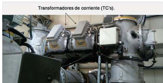
Figura 5.13: Ubicación de los transformadores de corriente en la subestación aislada en gas  $SF_6$ .
