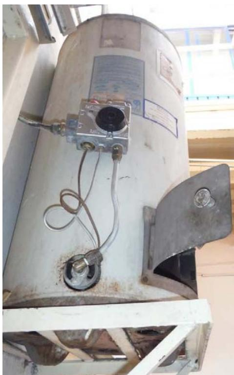
Ilustración 32 – Calentador de agua de deposito.
