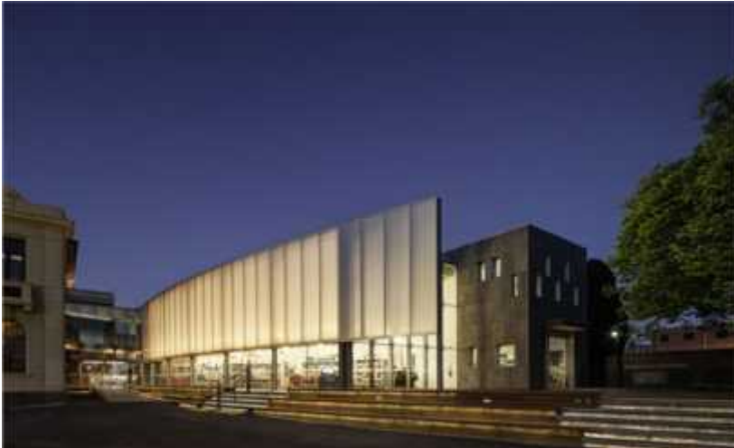
Foto 17.- Vista fachada principal.
