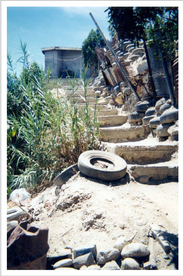
Lugar: Col. Obrera 3ª sección. Tijuana, B.C. Descripción: Escalera construida a partir del tequio Foto: Carolina Sánchez García Fecha: Junio - agosto 2002
