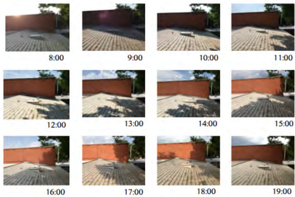
Figura 3.8: Registro fotográfico del sombreado en la azotea de la oficina de dirección en el IER-UNAM cada hora para el día 27 de mayo (día 147 juliano) del año 2015.
