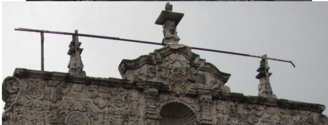
FIGURA 98. Remate del colegio de las Vizcaínas. FIGURA 99. Remate del antiguo colegio de San Ildefonso. FIGURA 100. Remate del ex cine Lindavista. Fotos. Jorge González.
