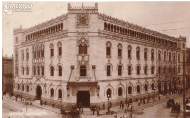
FIGURA 39. Vista general del Palacio Postal o Palacio de Correos. Foto. Obtenida de internet.
