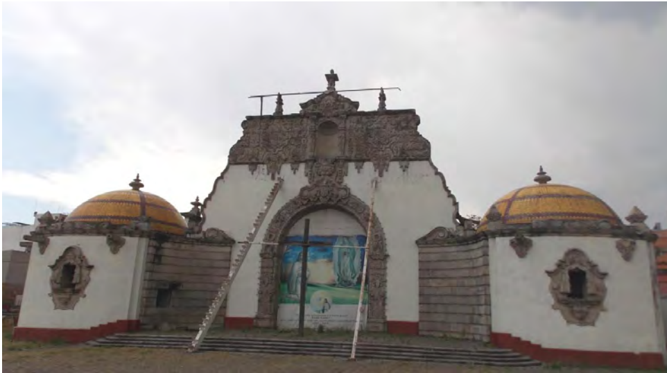
FIGURA 112. Vista actual de la fachada del ex cine Lindavista. Foto. Jorge González.
