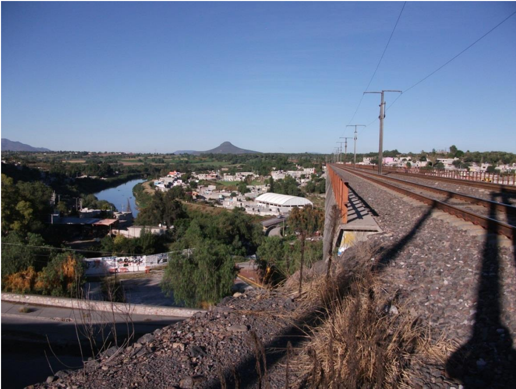
Imagen 19. Panorámica actual del viaducto Tula 2, obsérvese la cantidad de viviendas respecto a la imagen anterior, tanto el río Tula como el cerro “Xicuco” al fondo permanecen en el mismo lugar, noviembre 2015.
