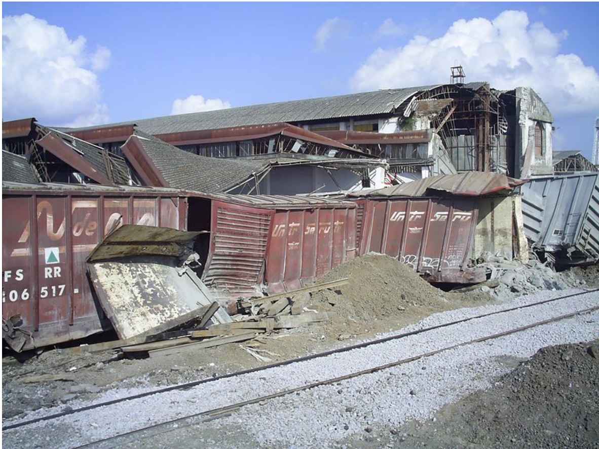
Imagen 5. Tren cementero que en el accidente se aprecia que dañó parte de una nave de uso industrial Foto: Miguel Ángel Florez, Córdoba Veracruz, 2005.
