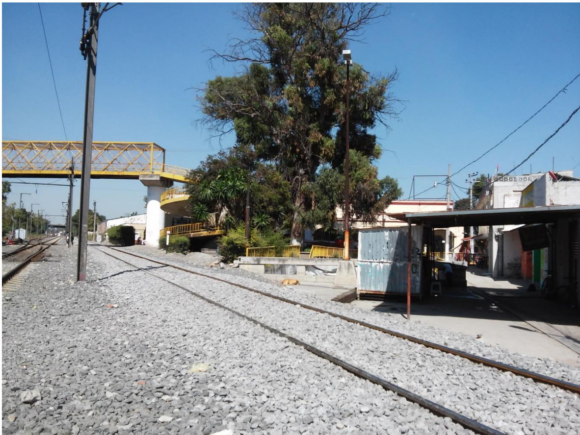
Imagen 16. Cerca del mismo ángulo en que se tomó la anterior fotografía se aprecia el mismo edificio (rosa al fondo) y la primera vía férrea a Querétaro o línea B, noviembre 2015.
