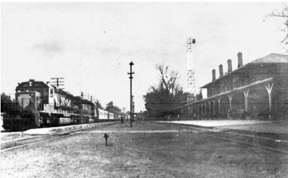
Imagen 17 Estación de Querétaro en el año 1974 previa a la construcción de las líneas Juárez y Morelos, se aprecia estas se hicieron dentro del derecho de vía de las líneas ya existentes al momento de su construcción. Colección propia.
