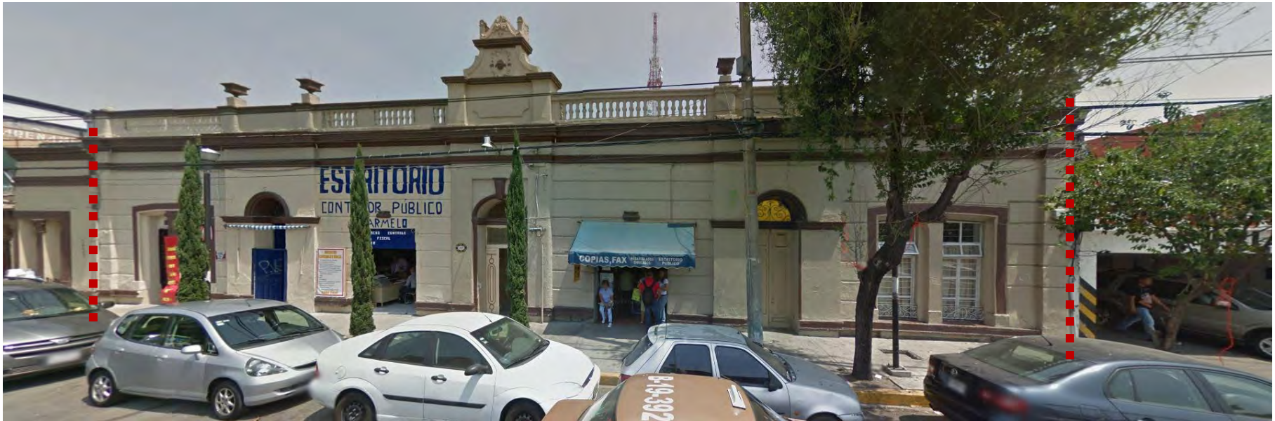
Vista de fachada catalogada
