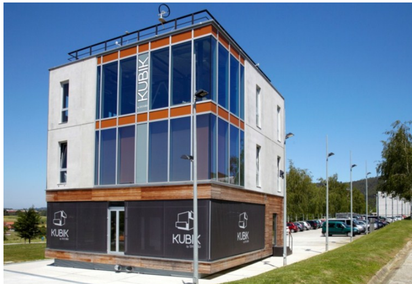
Imagen 1. Edificio Kubik by TecNALIA. Fuente: www.tecnalia.com Fecha de consulta: 16/01/17.
