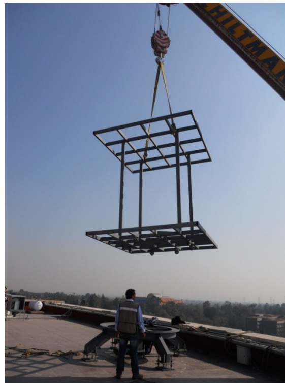
Imagen 11. Elevación estructura superior.
