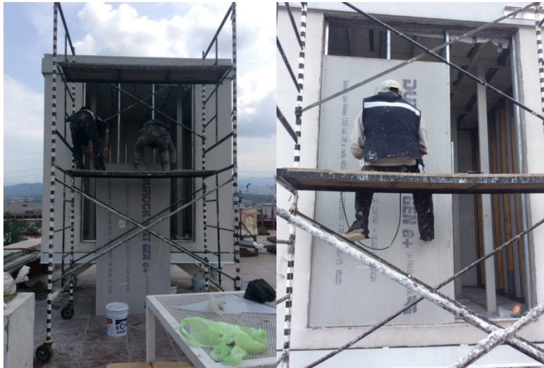
Imagen 32. Construcción y cierre vano de experimentación.
