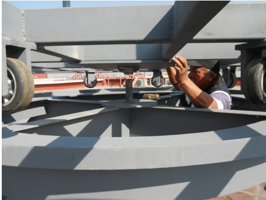
Imagen 12. Acoplamiento Estructura superior y base.
