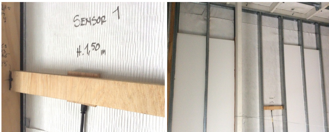
Imagen 33. Proceso de colocación del sensor Campbell Scientific 110 PV, al interior del muro.
