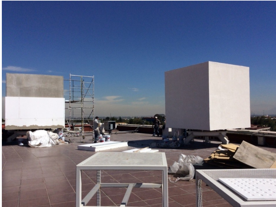
Imagen 18. Colocación del Sistema de aislamiento térmico en la envolvente. (PRECOR® de Corev)
