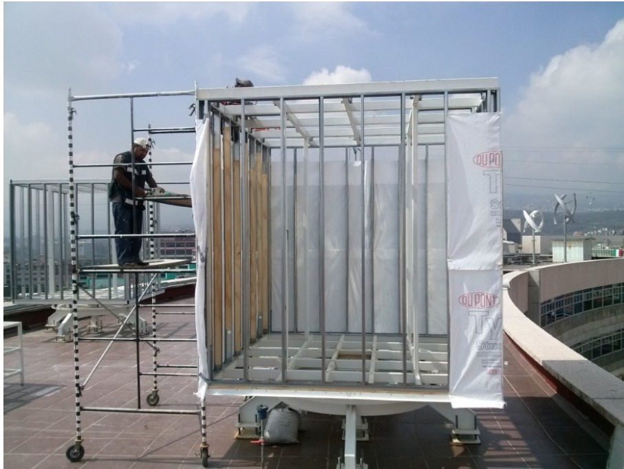
Imagen 16. Colocación de barrera de vapor.
