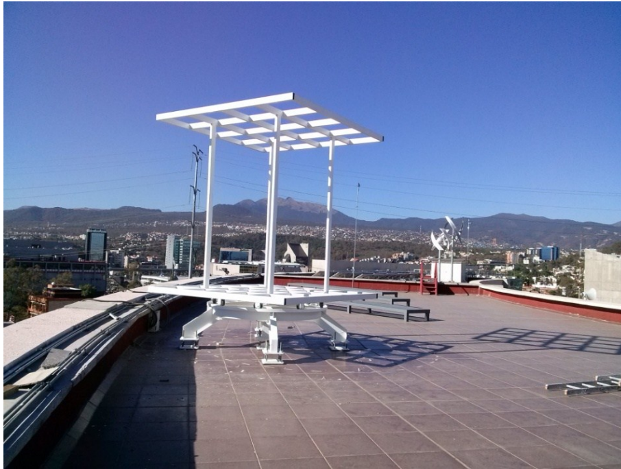
Imagen 14. Estructura pintada con anticorrosivo.
