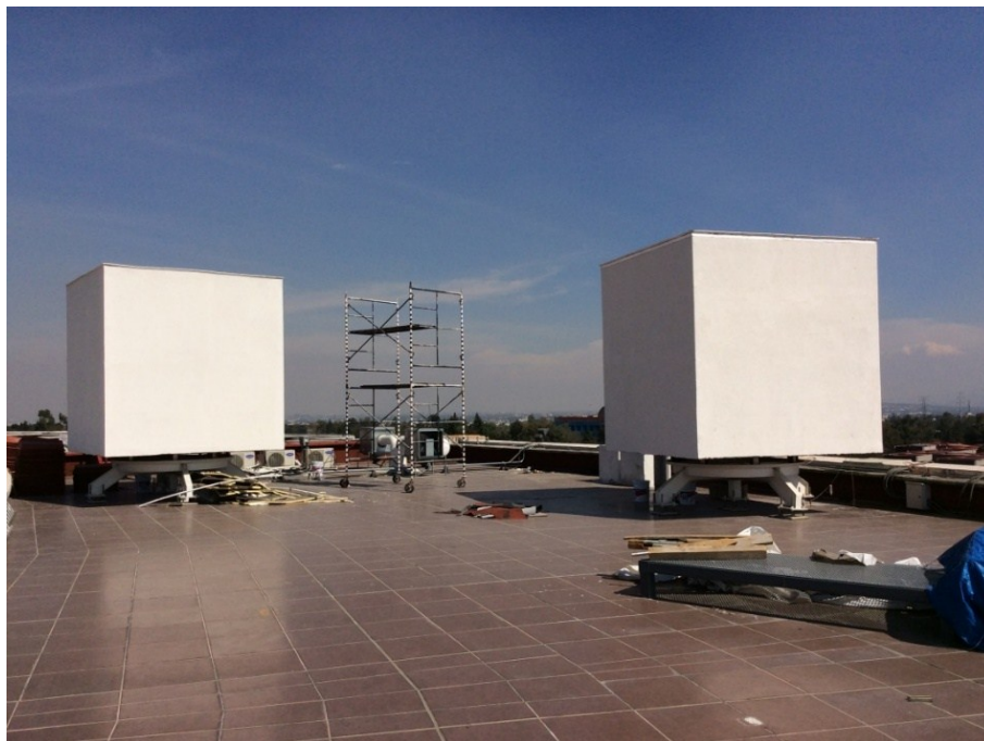
Imagen 19. Envolvente exterior terminada.
