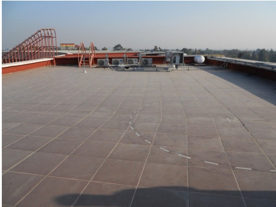
Imagen 8. Trazo y ubicación de la base en la azotea.
