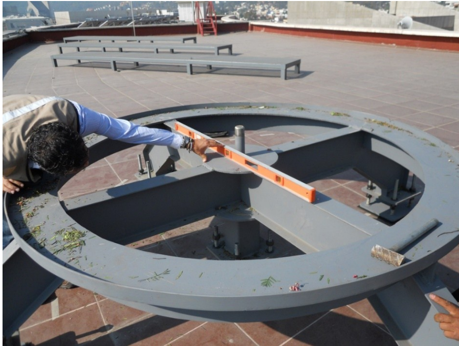
Imagen 10. Nivelación de la base.
