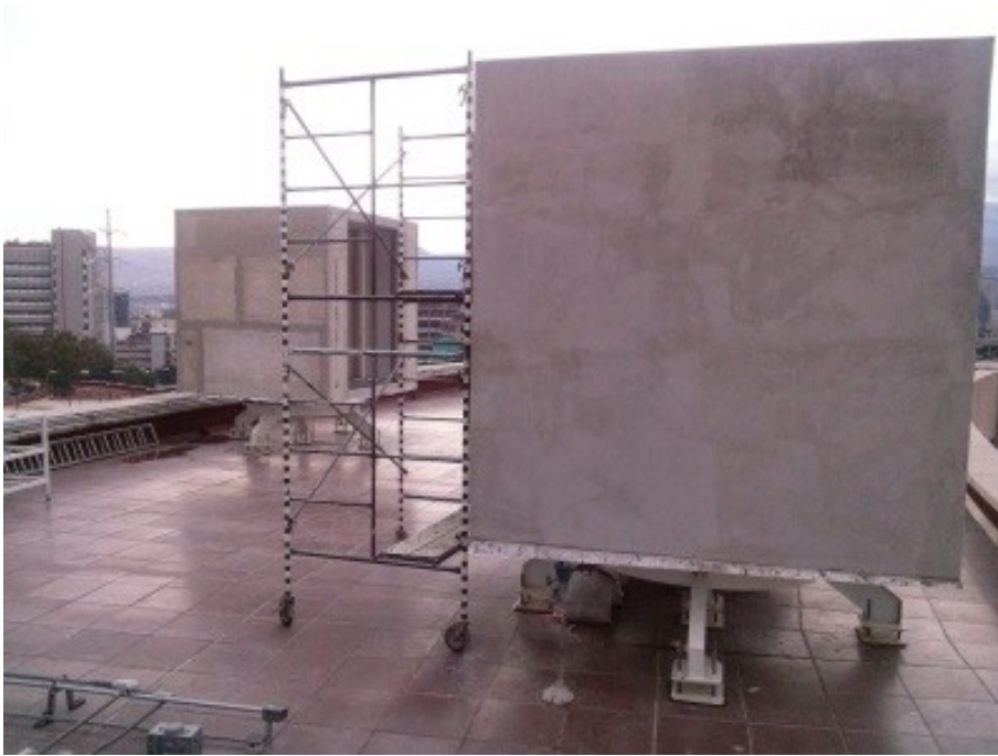
Imagen 5. Sustrato base de la envolvente exterior.
