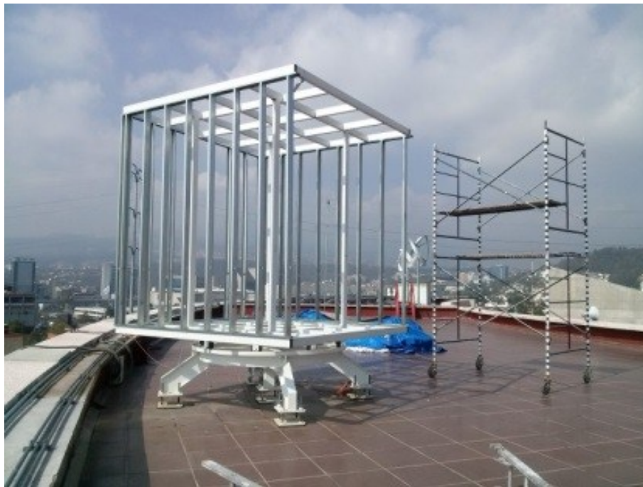
Imagen 4. Proceso de fabricación del bastidor para la envolvente.
