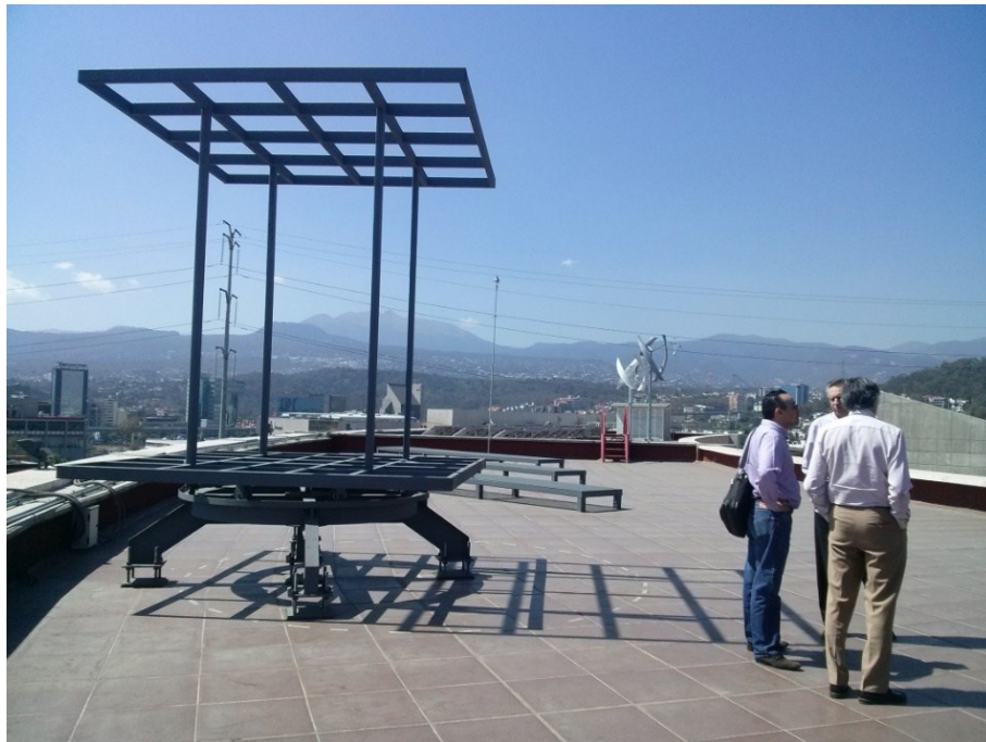
Imagen 13. Estructura y base montadas.
