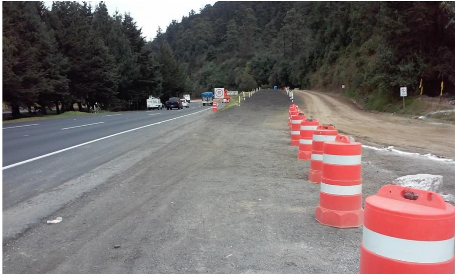
Imagen 2: Entrada a la Rampa de Frenado de Emergencia
