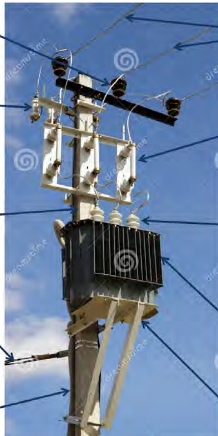
Figura 3.6 Ejemplo de una subestación aérea de distribución.
