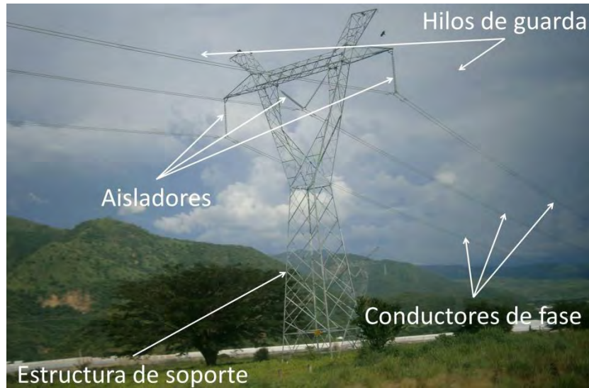
Figura I.12 Componentes de una línea de transmisión.
