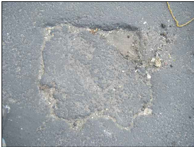
Figura III.27. Tapa de caja de válvula que requiere desasfaltado. Fuente: PSC, 2013.
