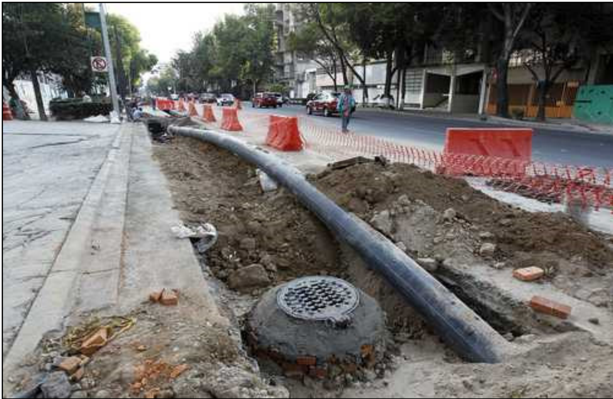
Figura II.25. Obras de rehabilitación de una red de agua potable. Fuente: http://www.jornada.unam.mx/2015/02/27/capital/040n2cap . [Consulta: 29 julio 2016].
