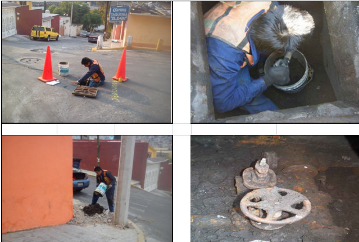
Figura III.34. Proceso de desazolve de una caja de válvulas. Fuente: PSC, 2013.
