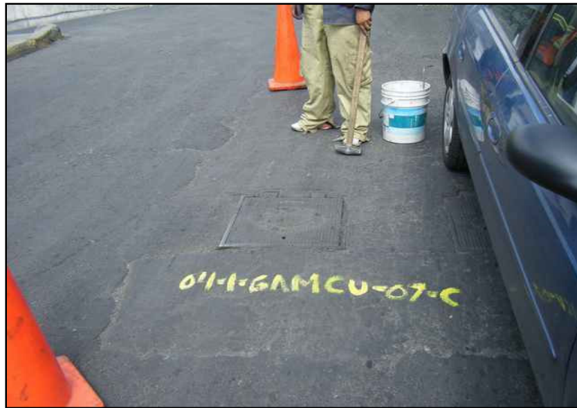
Figura III.30. Tapa de caja de válvulas que requiere de apertura. Fuente: PSC, 2013.
