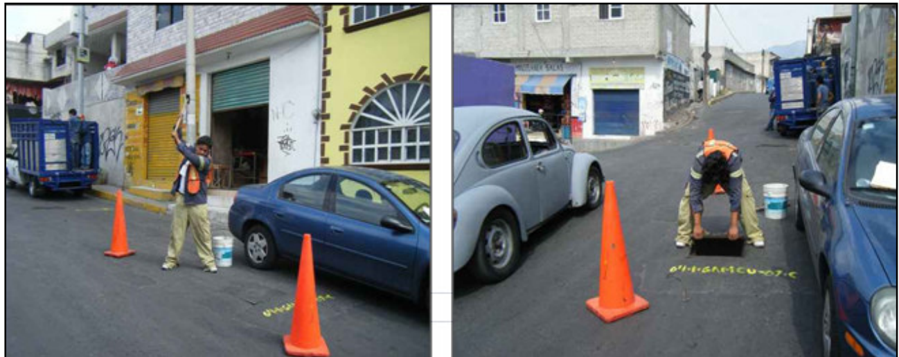
Figura III.31. Proceso de apertura de una caja de válvulas. Fuente: PSC, 2013.
