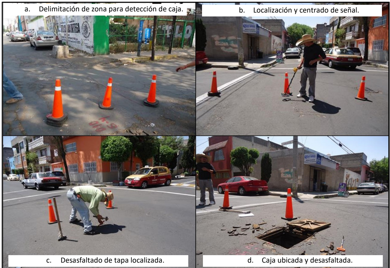
Figura III.21. Localización de cajas con apoyo de detector de metales. Fuente: PSC, 2013.
