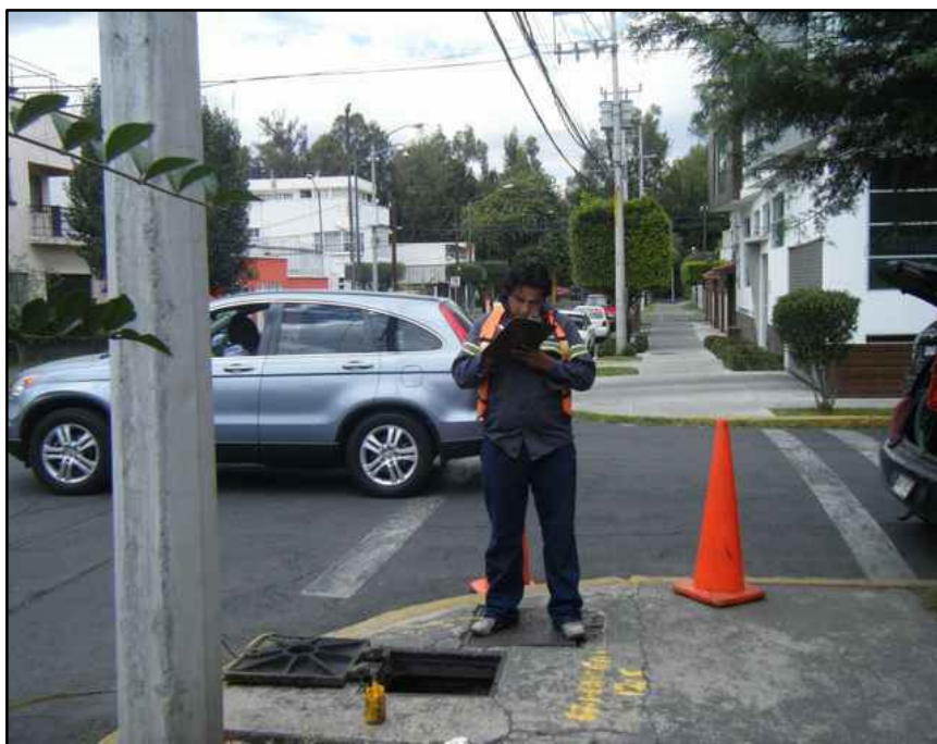
Figura III.14. Ubicación típica de las cajas de válvula. Fuente: PSC, 2013.
