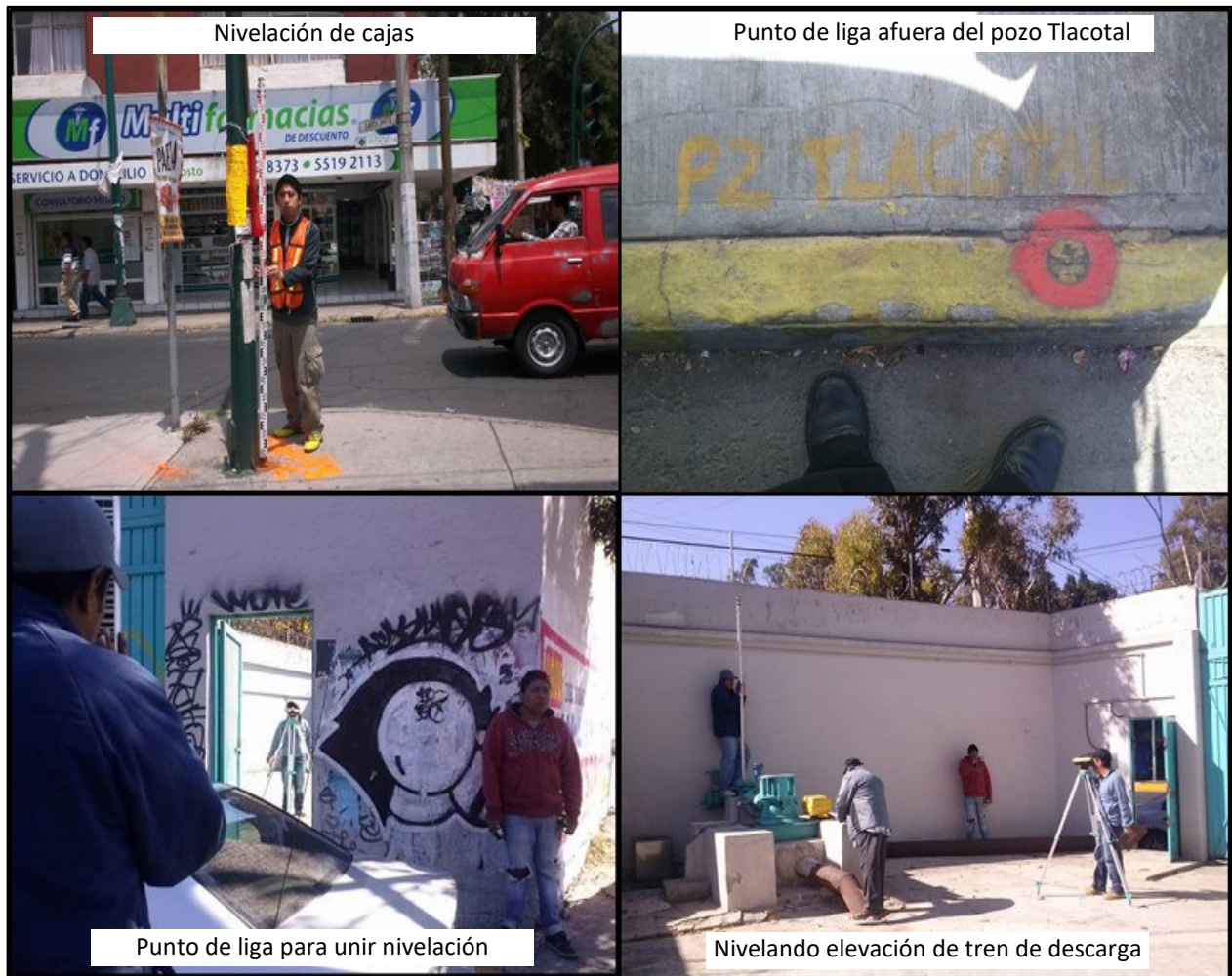
Figura III.10. Proceso de nivelación de tapas en la delegación GAM. Fuente: PSC, 2013.
