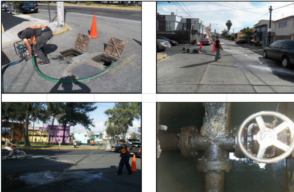
Figura III.36. Proceso de achique de una caja de válvulas. Fuente: PSC, 2013.
