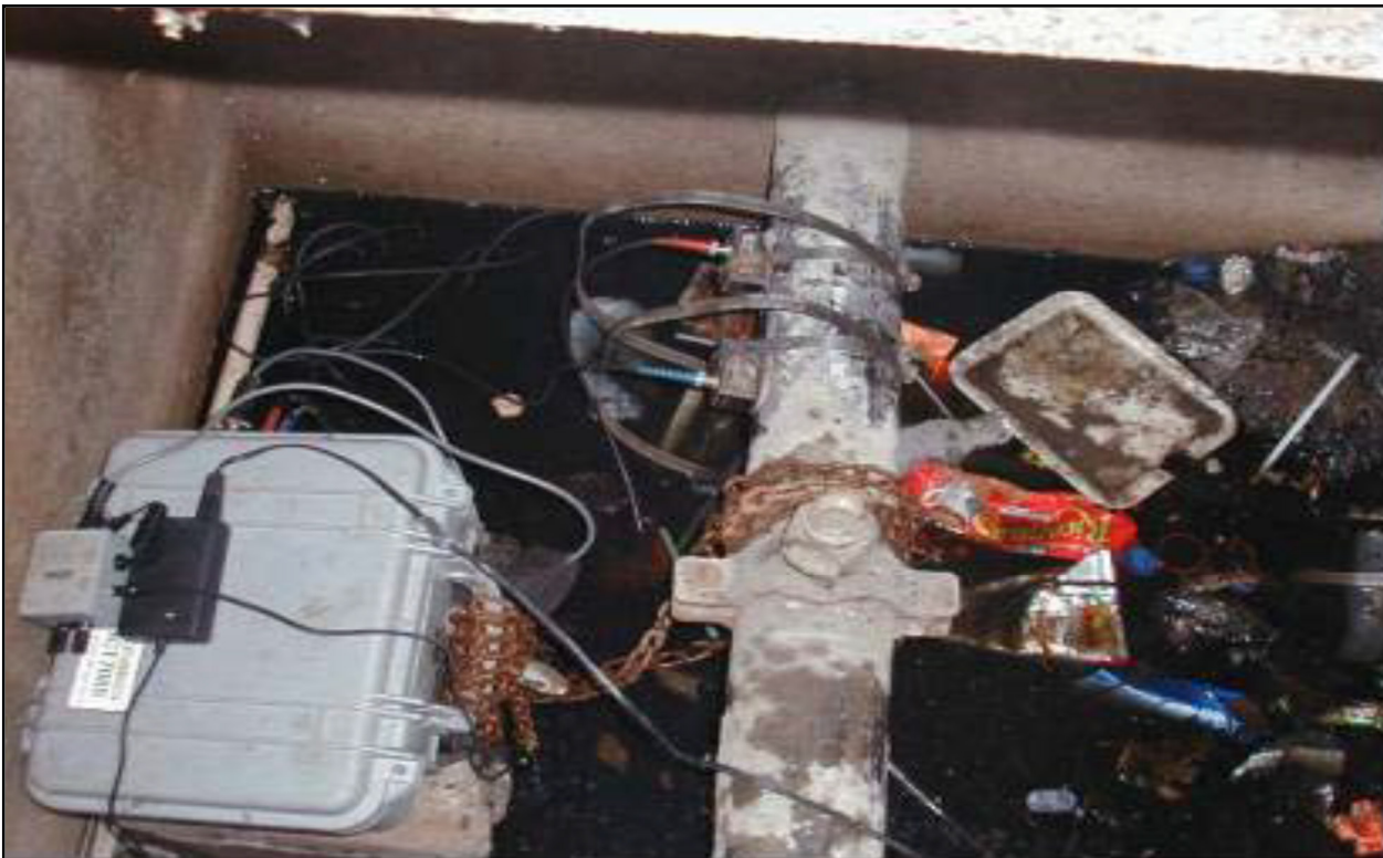
Figura II.26. Medición de presión y gasto en tuberías. Fuente: Martínez, 2003.
