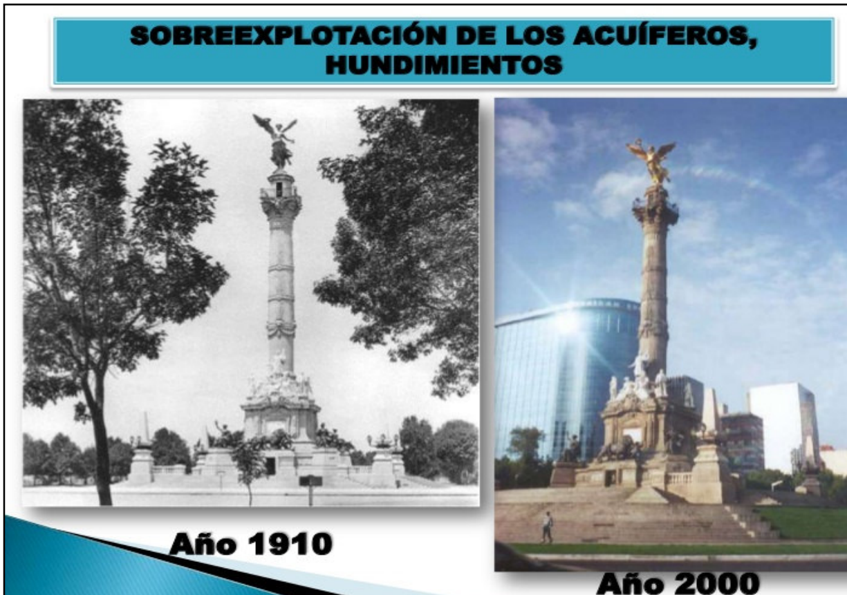
Figura I.16. Hundimientos por sobreexplotación de acuíferos. Fuente: Robledo, 2011.
