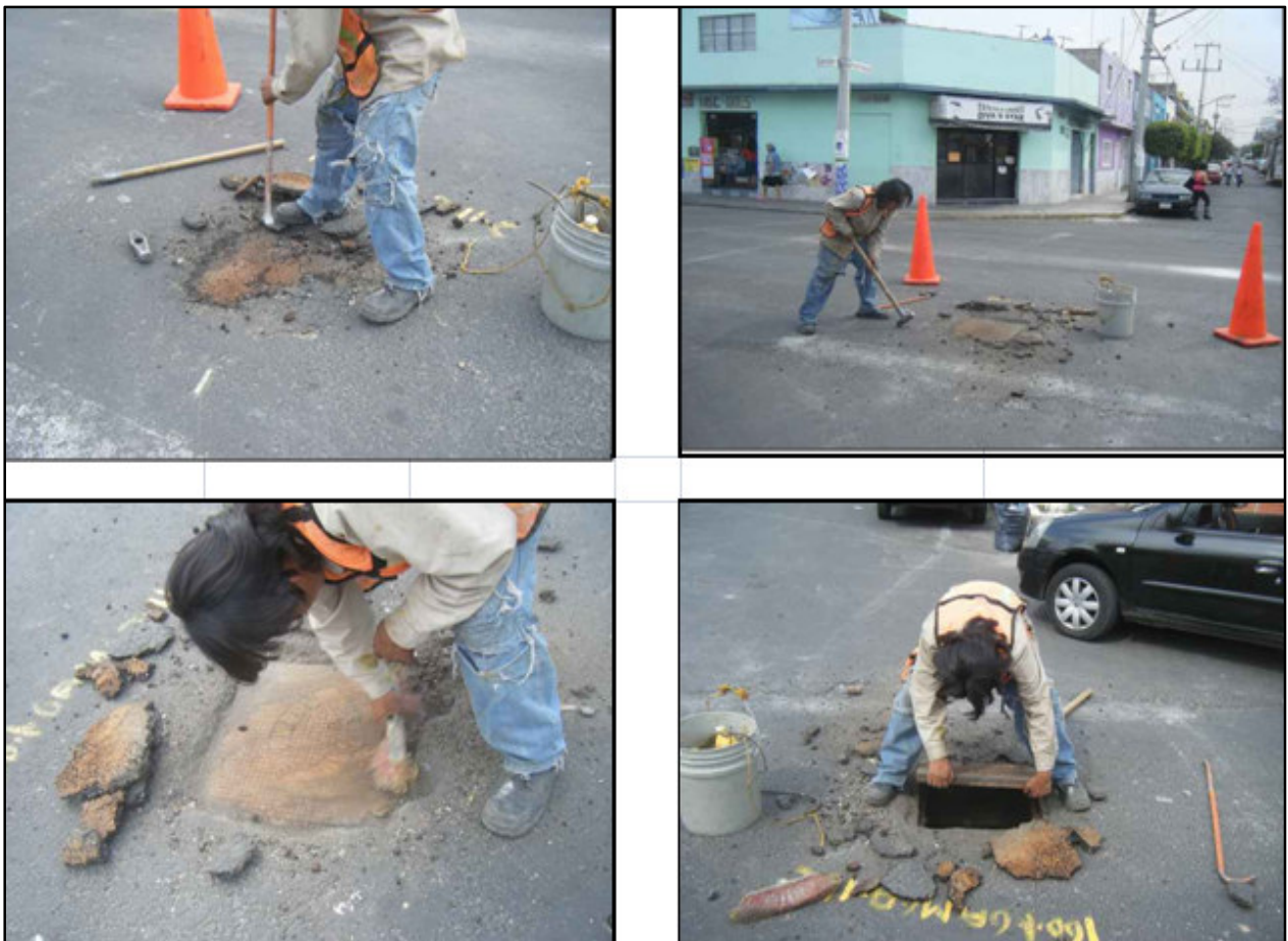
Figura III.28. Proceso de desasfaltado de una caja de válvulas. Fuente: PSC, 2013.
