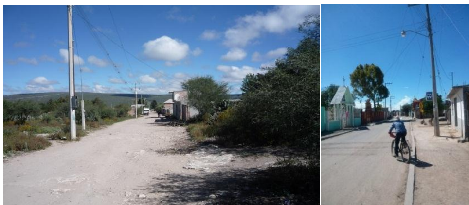
Figura 21. Red eléctrica en las calles de la Misión.
