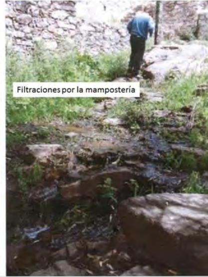
Figura 6.8. La cortina tiene fugas o filtraciones por la mampostería.
