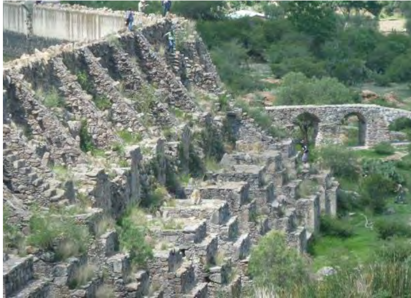
Figura 6.1. Presa Los Arcos, Aguascalientes, México
