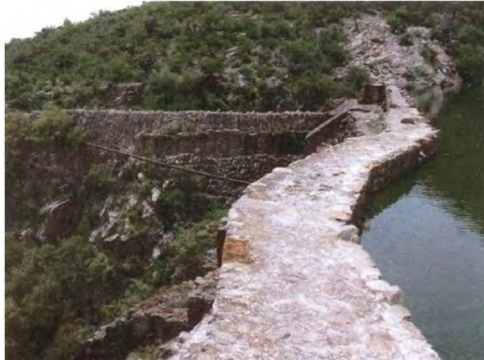
Figura 6.6. La cortina tiene un eje serpenteante.
