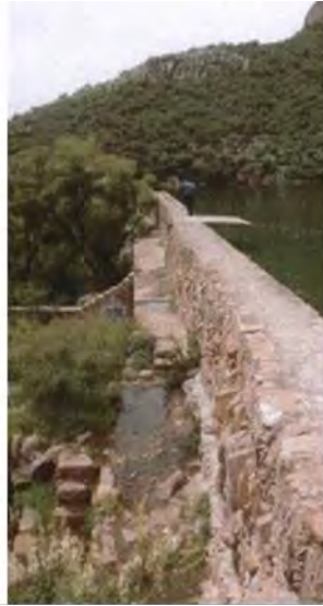
Figura 6.8. La cortina tiene fugas o filtraciones por la mampostería.
