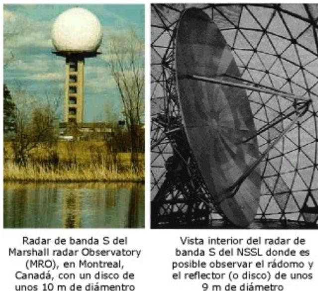
Figura 1.14: Radares de banda S. (Fuente: Centre de Recerca Aplicada en Hidrometeorología (CRAHI))
