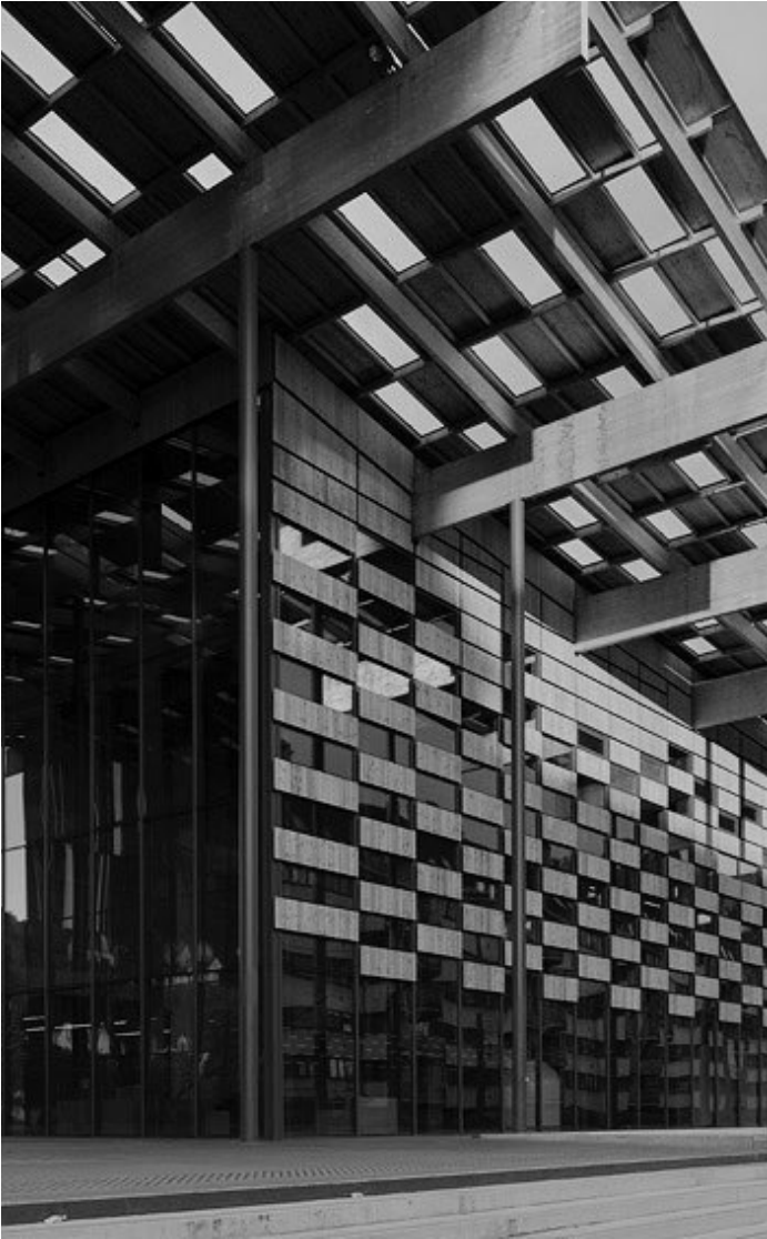
Fachada sureste, edificio Cité de Arts de la Culture, Francia, Kengo Kuma and Associates, foto Nicolas Waltefaugle
