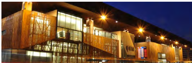
Fachada principal, Centro Cultural Gabriela Mistral, Lateral arquitectura & diseño, Cristián Fernández, foto Marcos Mendizábal.
