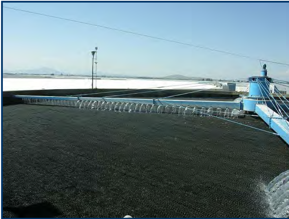
Figura No. 37. Medio filtrante y brazo rotatorio. Fuente del autor.
