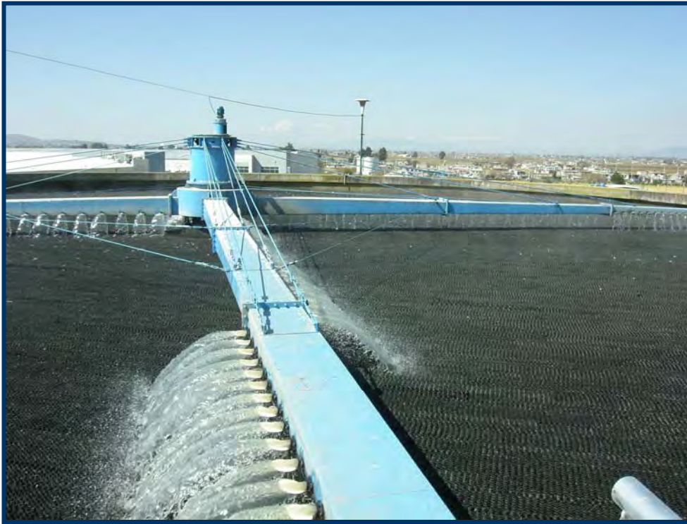
Figura No. 39. Distribuidor Rotatorio. Fuente del autor.
