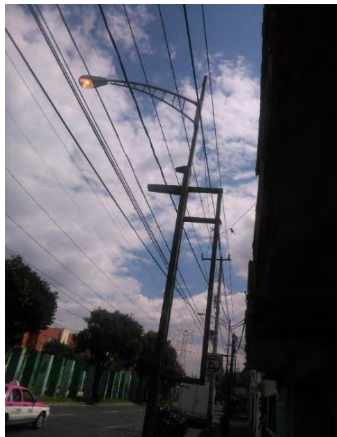
FIG 105: fotos de altura de montaje y operación incorrecta de luminaria
