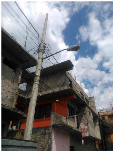
FIG 105: fotos de altura de montaje y operación incorrecta de luminaria
