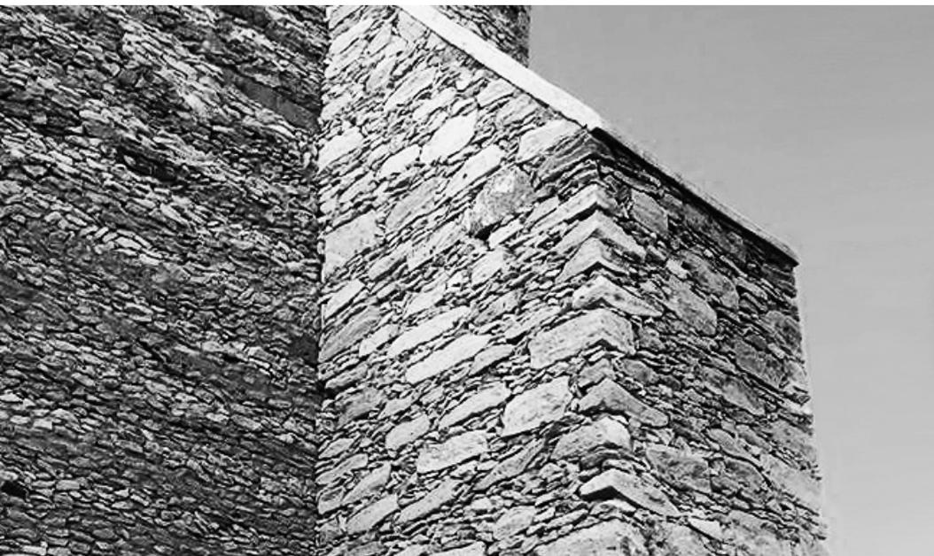
*Foto 3: Contrafuertes. Evidencia del uso del arco y la bóveda.
