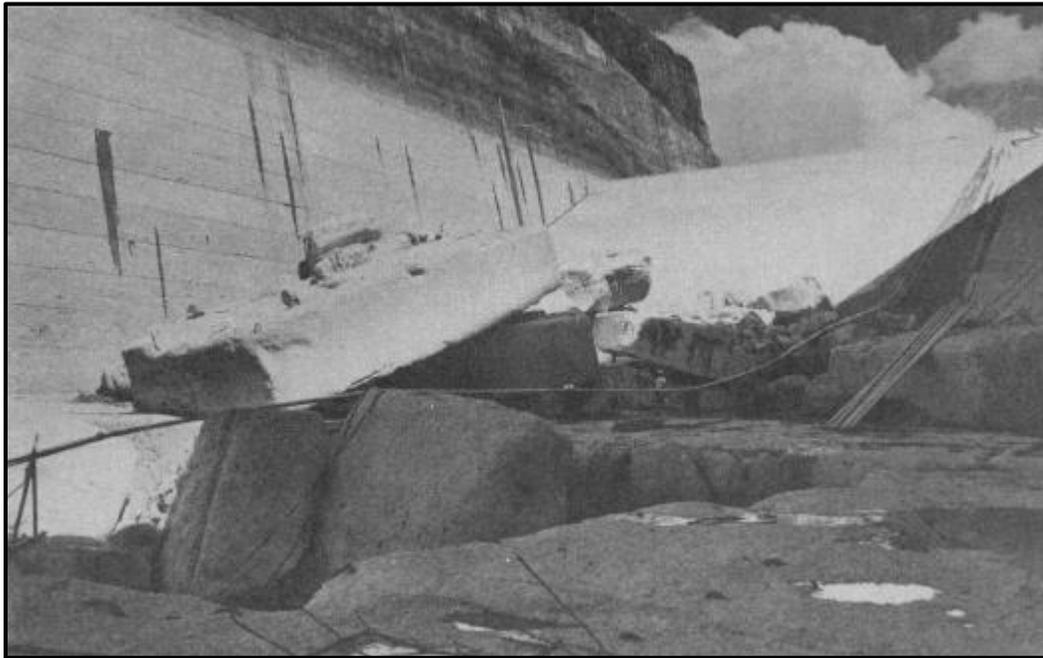
*Figura 1.13 Vista en la elevación 70 del tanque de amortiguamiento dañado
