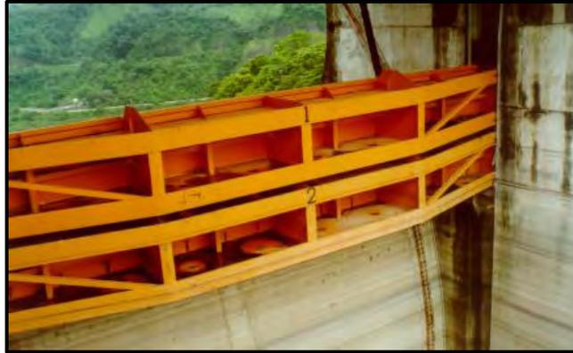
*Figura 1.16 Obturadores utilizados de pantalla en la emergencia de 1999
