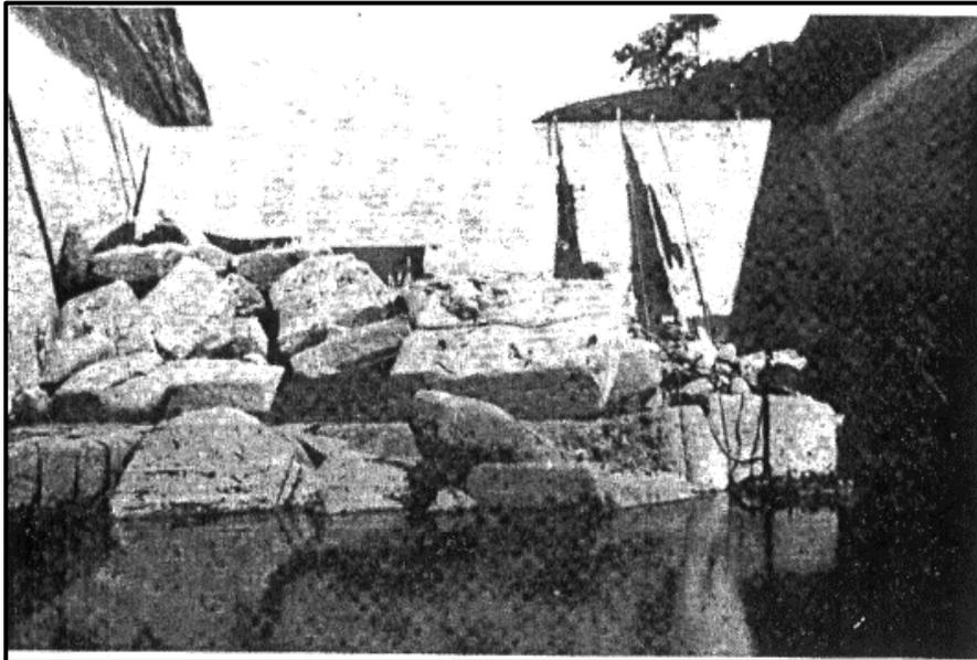
*Figura 3.6 Vista aguas abajo del daño en el revestimiento
