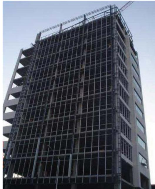
Imagen 5. Fachada integral suspendida con perfiles de aluminio portante vertical y horizontal. Fuente: Navarro A. 2011
