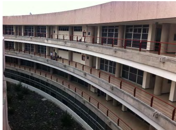
Figura 7. La circulación en los edificios. La disposición de andadores y espacios de actividad estimulan el flujo de peatones en los edificios. Unidad de posgrado UNAM (2016).
