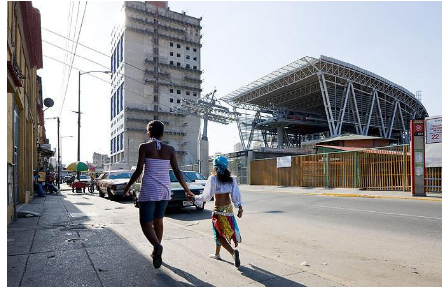
Fig. 1.3.5 Edificio de viviendas junto a una estación del Metrocable. ArchDaily: Metro Cable de Caracas Urban Think Tank
