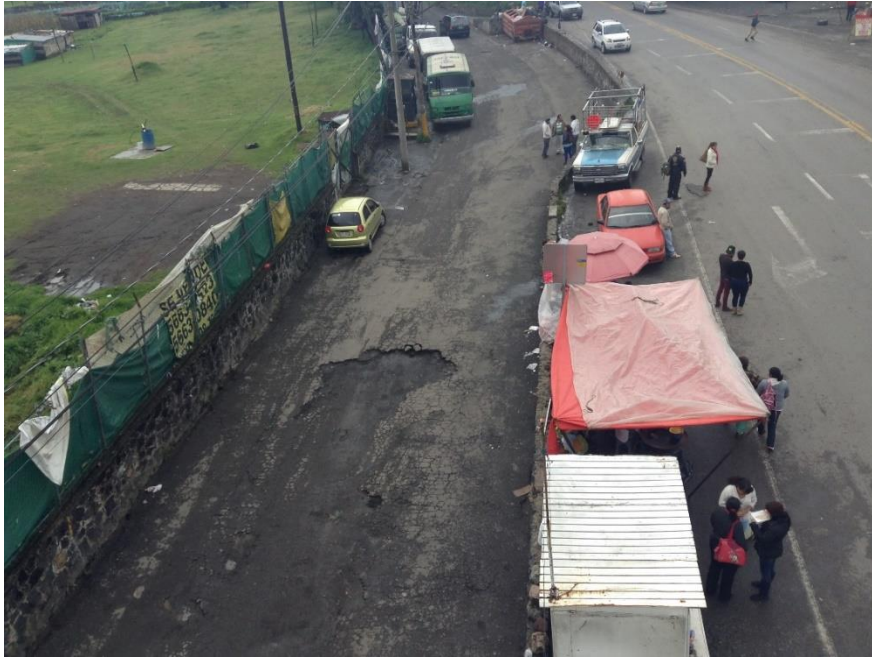
Fig. 2.4.10 Desnivel del terreno con respecto al nivel de la carretera. Entre la carretera y la calle Miguel Hidalgo se encuentra un muro de contención, así como entre la calle Miguel Hidalgo y el terreno, este muro de contención rodea todo el terreno.
